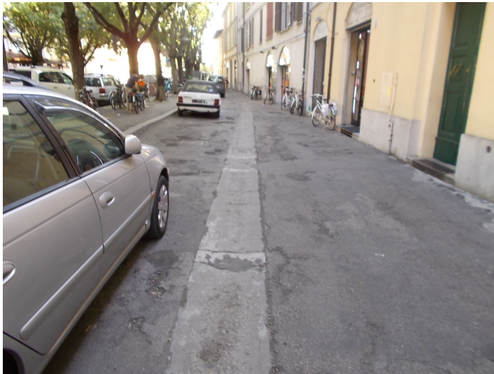
Corso Garibaldi – controstrada laterale
